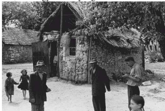
17. Jól látható a hagyományos ágasfás-szelemenés szerkezete ennek a nyitott padlású házacskának.
